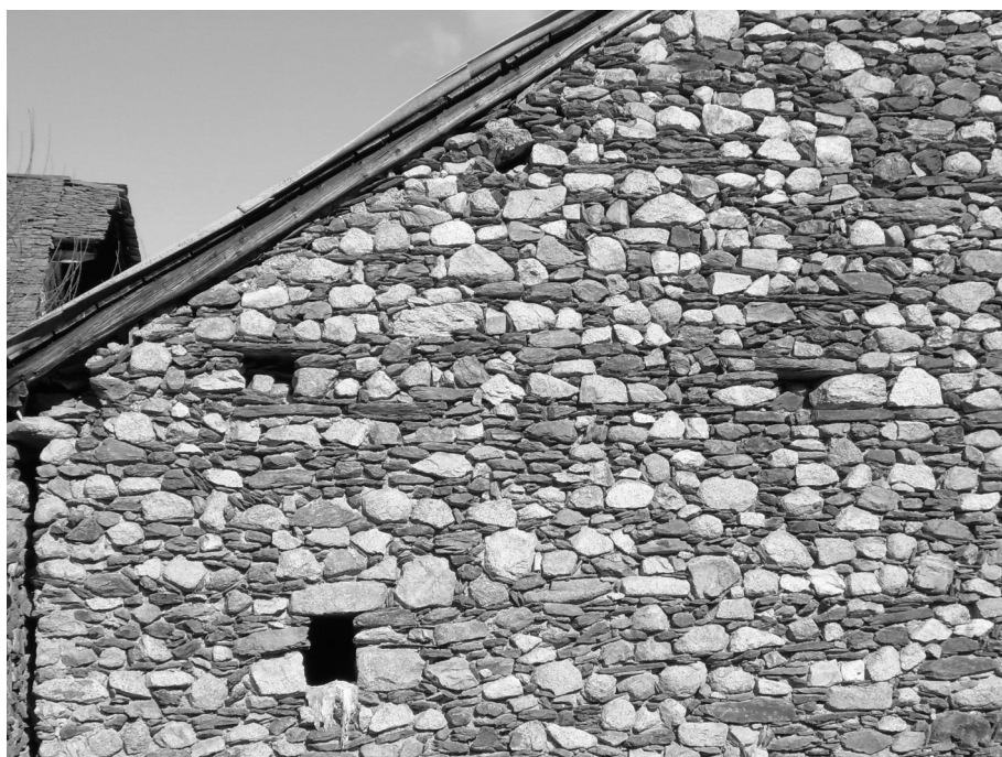
FIGURA 25. La proporció de cairells de gresos i pissarres del Cambroordovicià (roques fosques) i de granitoides (roques clares) és similar a la major part dels edificis de Son. Les lloses gruixudes de gresos i pissarres s'aprofiten per fer fileres regulars. Els cairells de granitoides són relativament irregulars. Per a les petites llindes s'utilitzen indistintament lloses o carreus de granitoides. En segon terme, es veu el llosat d'una casa, colonitzat per líquens.
