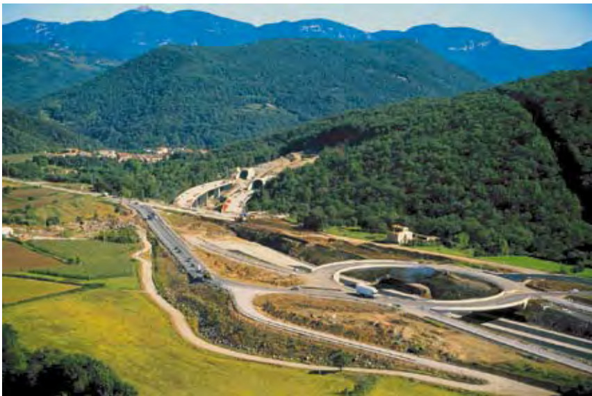
Figura 4.10 Imatge aèria de l'autovia N-260 al Pla de Begudà, dins el Parc Natural de la Zona Volcànica de la Garrotxa. El Ministeri de Foment ha dut a terme pràcticament tota l'obra sense projecte constructiu ni avaluació d'impacte ambiental, de manera que s'ha acabat aïllant tot el sector de la serra d'Aiguanegra; a més, no hi ha un sol pas de fauna en 4 km
